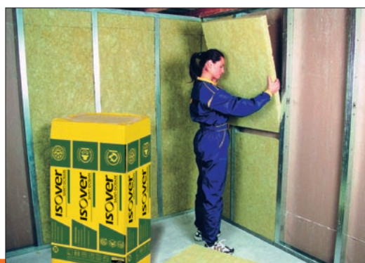
Ukázka aplikace výrobku Isover AKU
