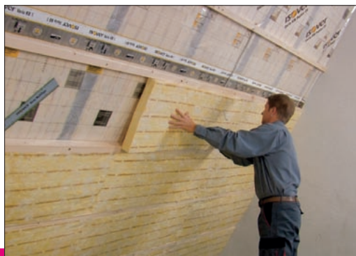
Die Beispielapplikation des Isover UNIROL PROFI
